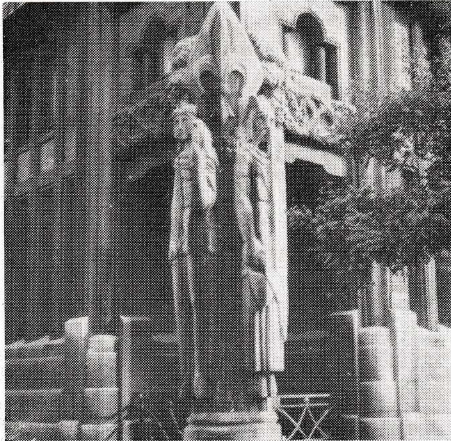
Pilier d'angle du beffroi de la mairie
